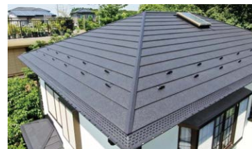
元旦内樋(住宅用)、断熱ビューティルーフ2型(住宅用横葺き金属屋根)施工物件
